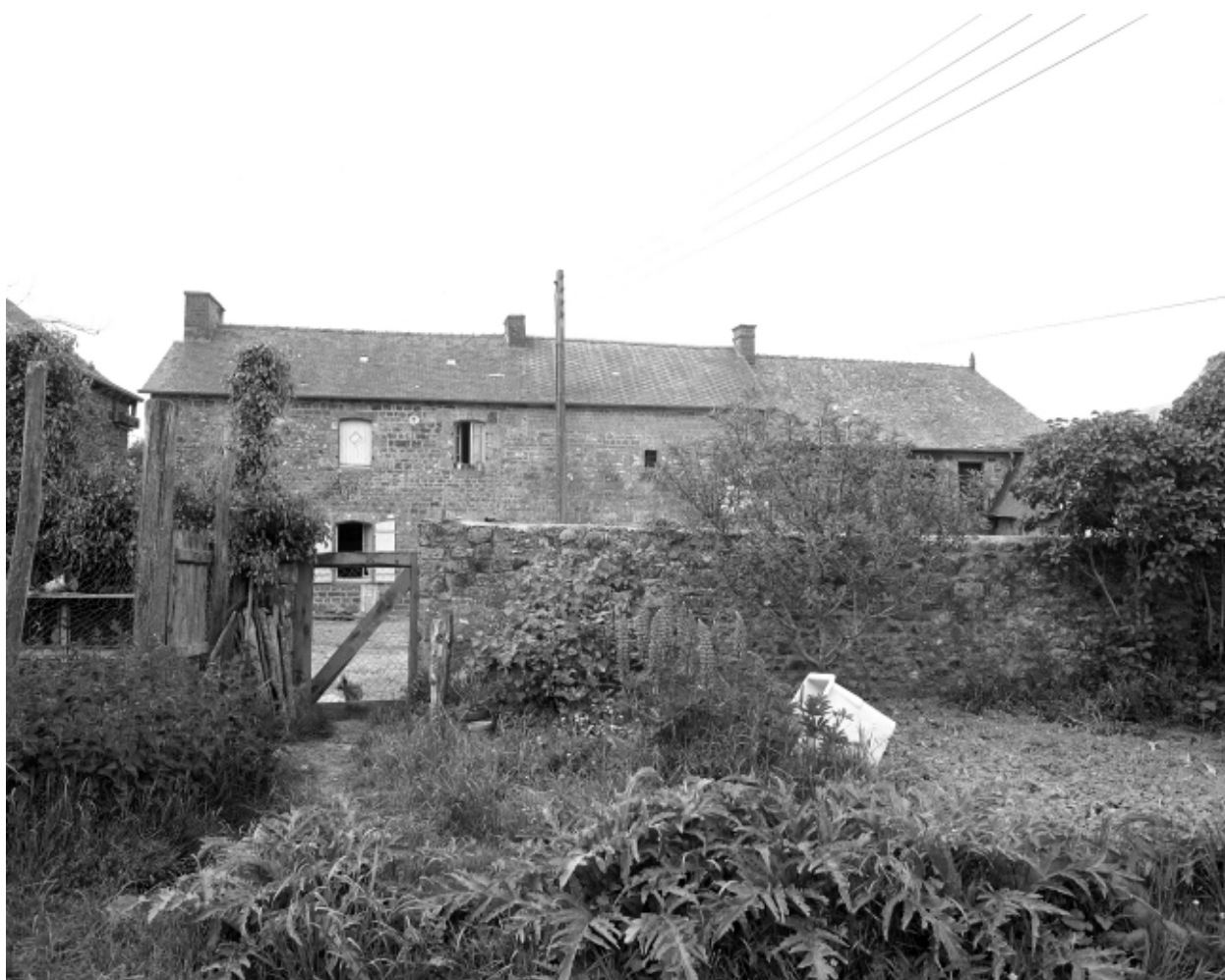
Alignement, vue générale.
