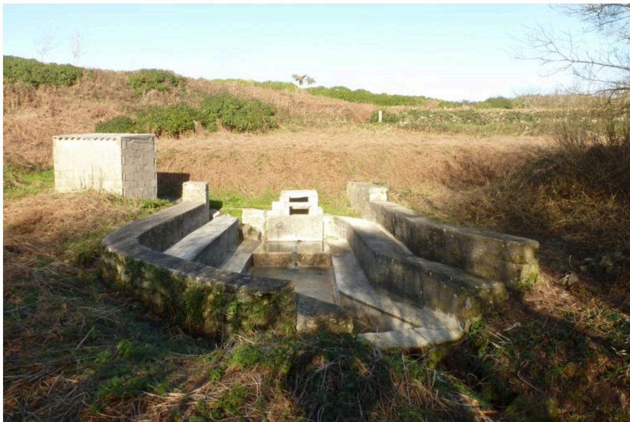
Lavoir et fontaine dite "de Lescoff", vue générale prise du sud-ouest. Cabane des laveuses.
