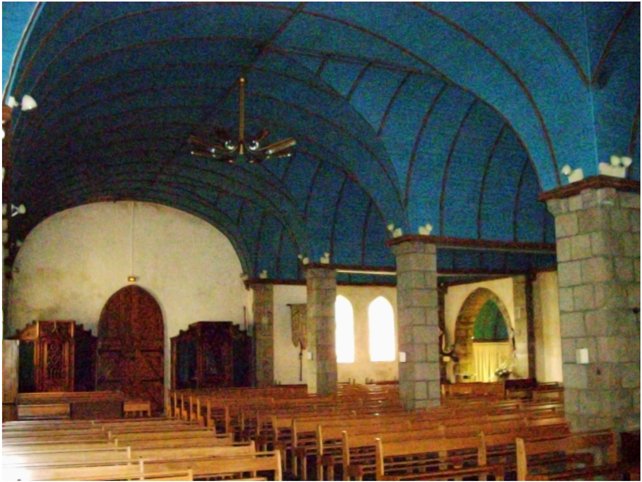
Plouhinec, église paroissiale de Poulgoazec : vue transversale nord-ouest
