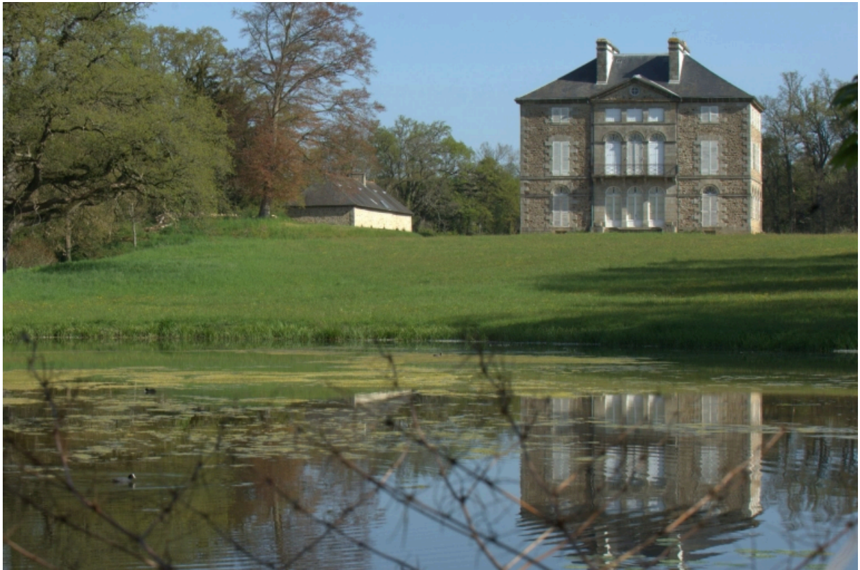
Château, vue générale sud
