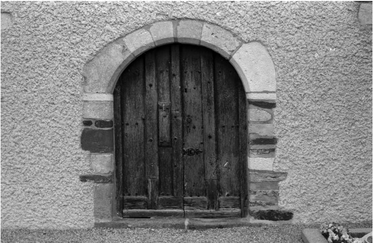
Eglise Saint-Melaine, entrée sud
