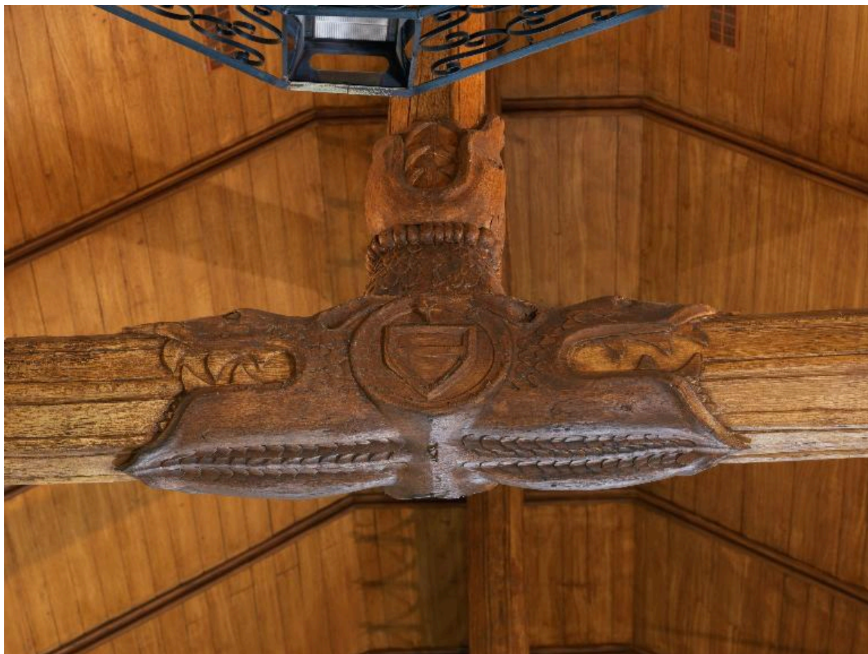
Engoulants de la charpente
