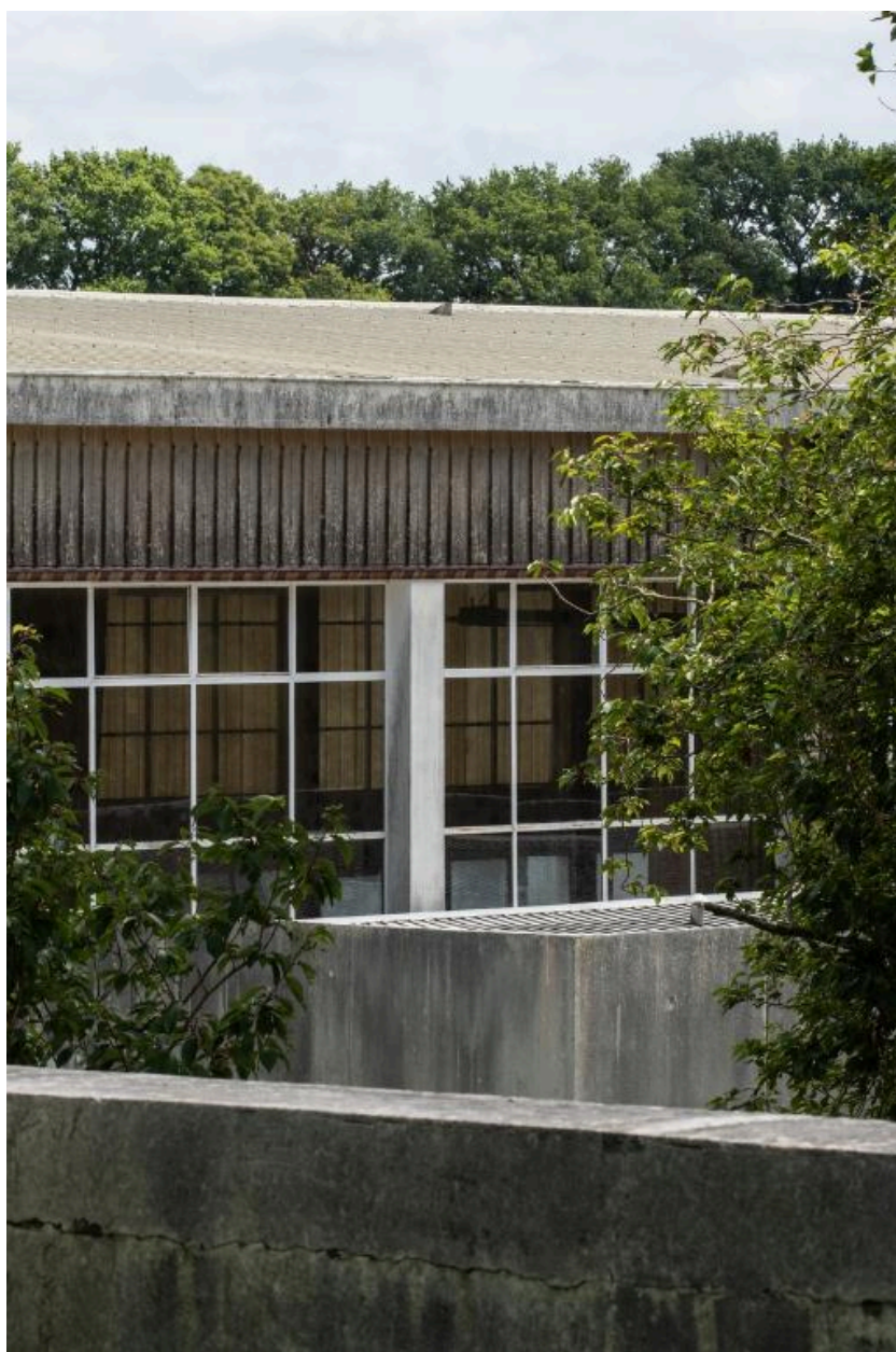
Gymnase, façade ouest. Vue partielle. Péron et Weisbein, architectes, 1968.
