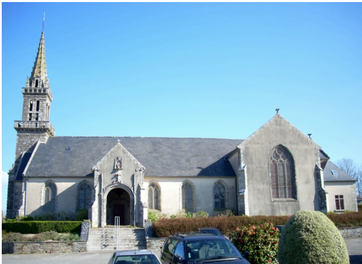
Lennon, église paroissiale de la Sainte-Trinité : élévation sud
