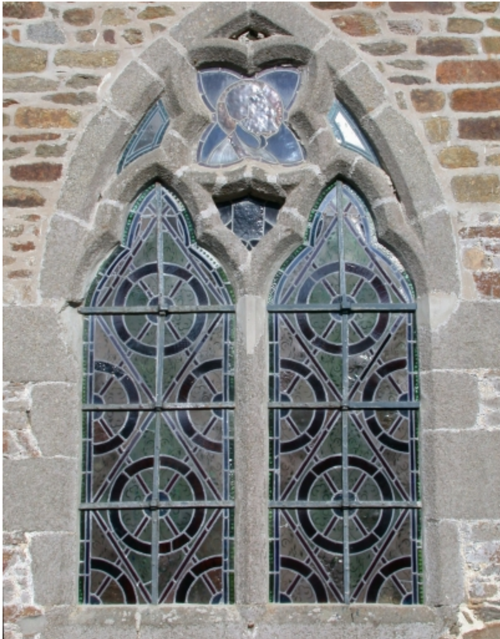
Nef, mur sud, (baie 12)
