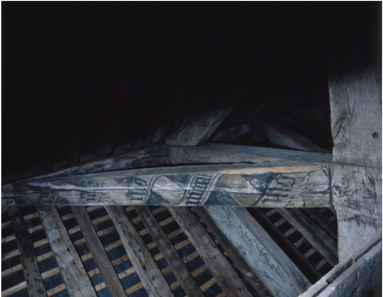
Détail sous charpente.
