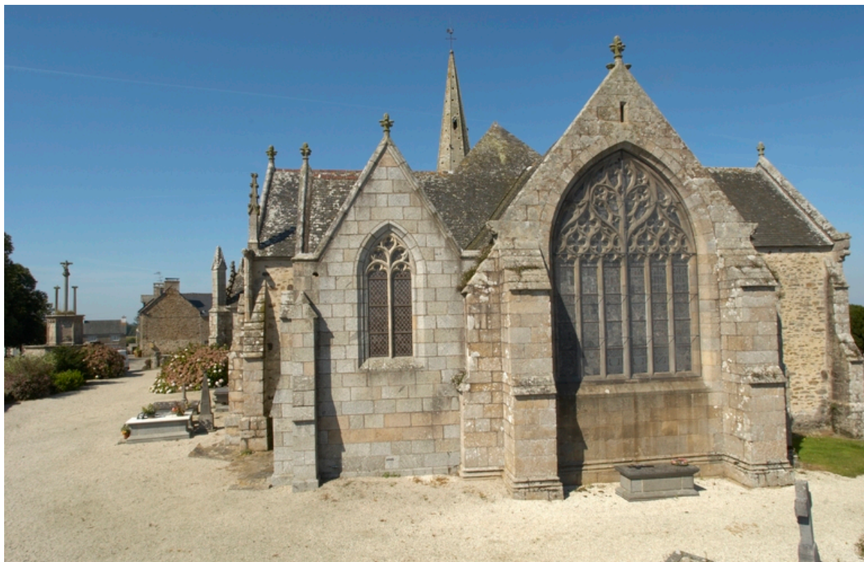
Vue générale du chevet
