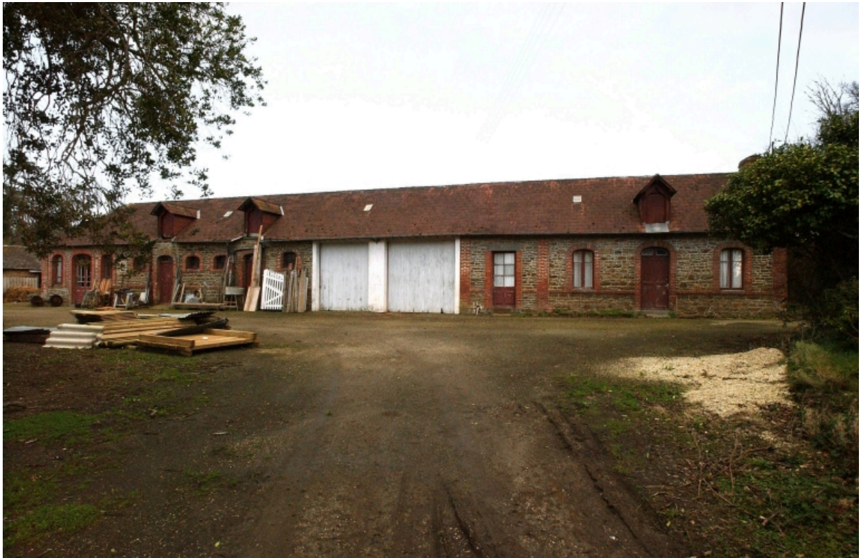
Les communs : vue générale ouest
