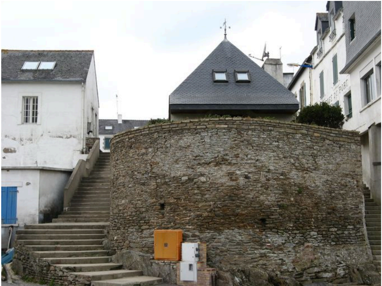
Corps de garde amont vu du quai
