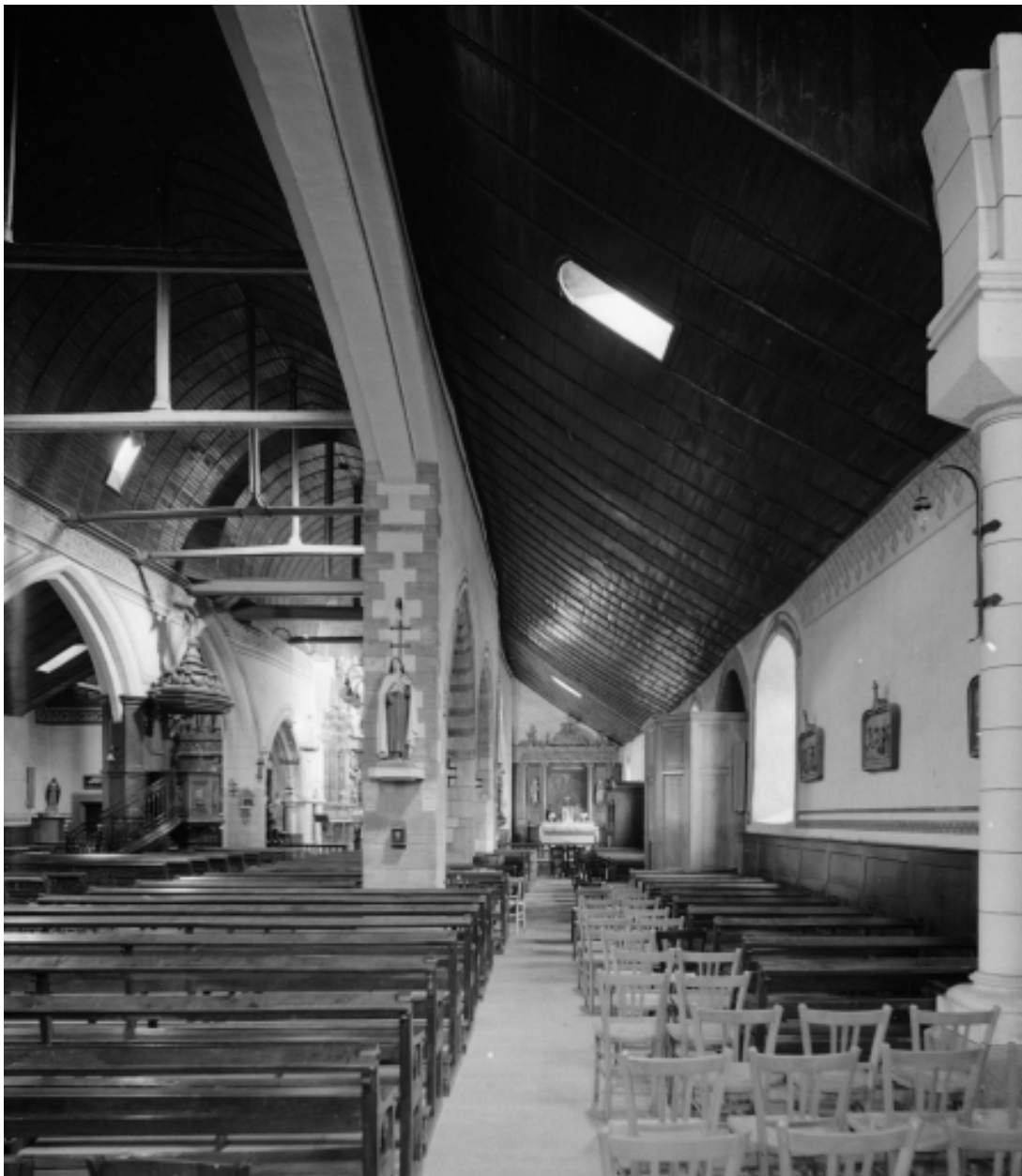
Bas-côté sud, vue vers l'est.
