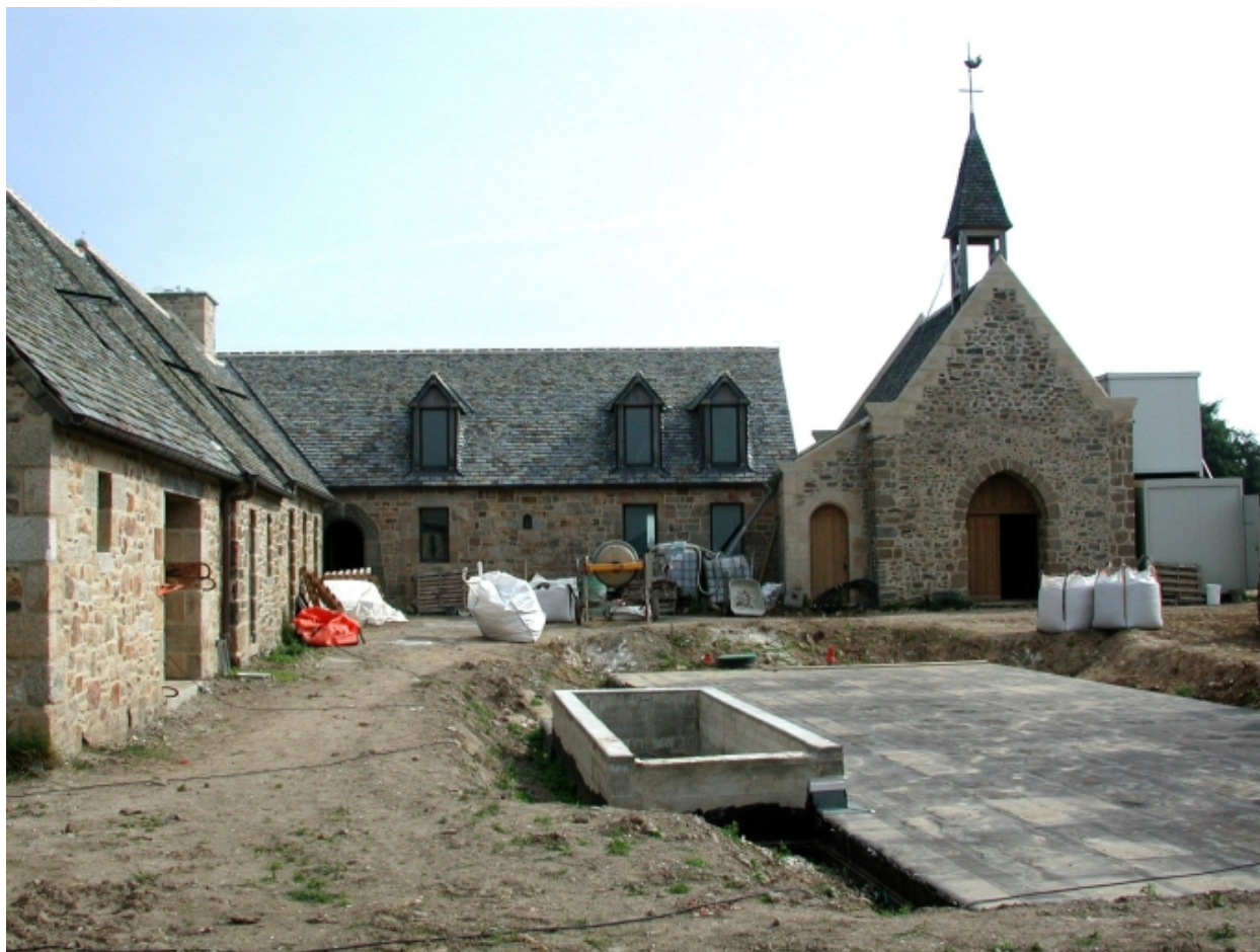
Vue des bâtiments et de la cour en travaux (mini station d'épuration)
