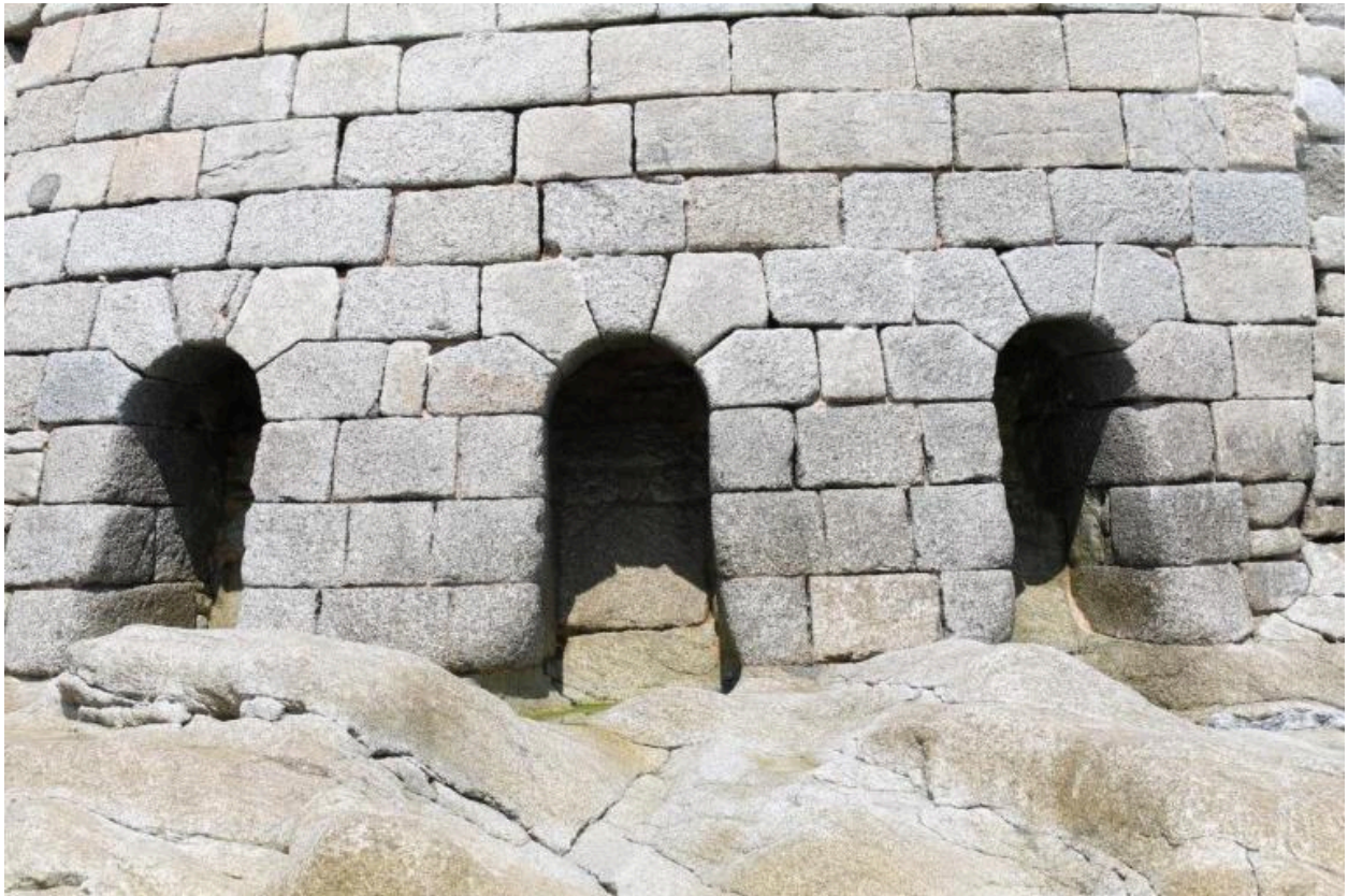
Vue extérieure des évacuations des lieux d'aisance
