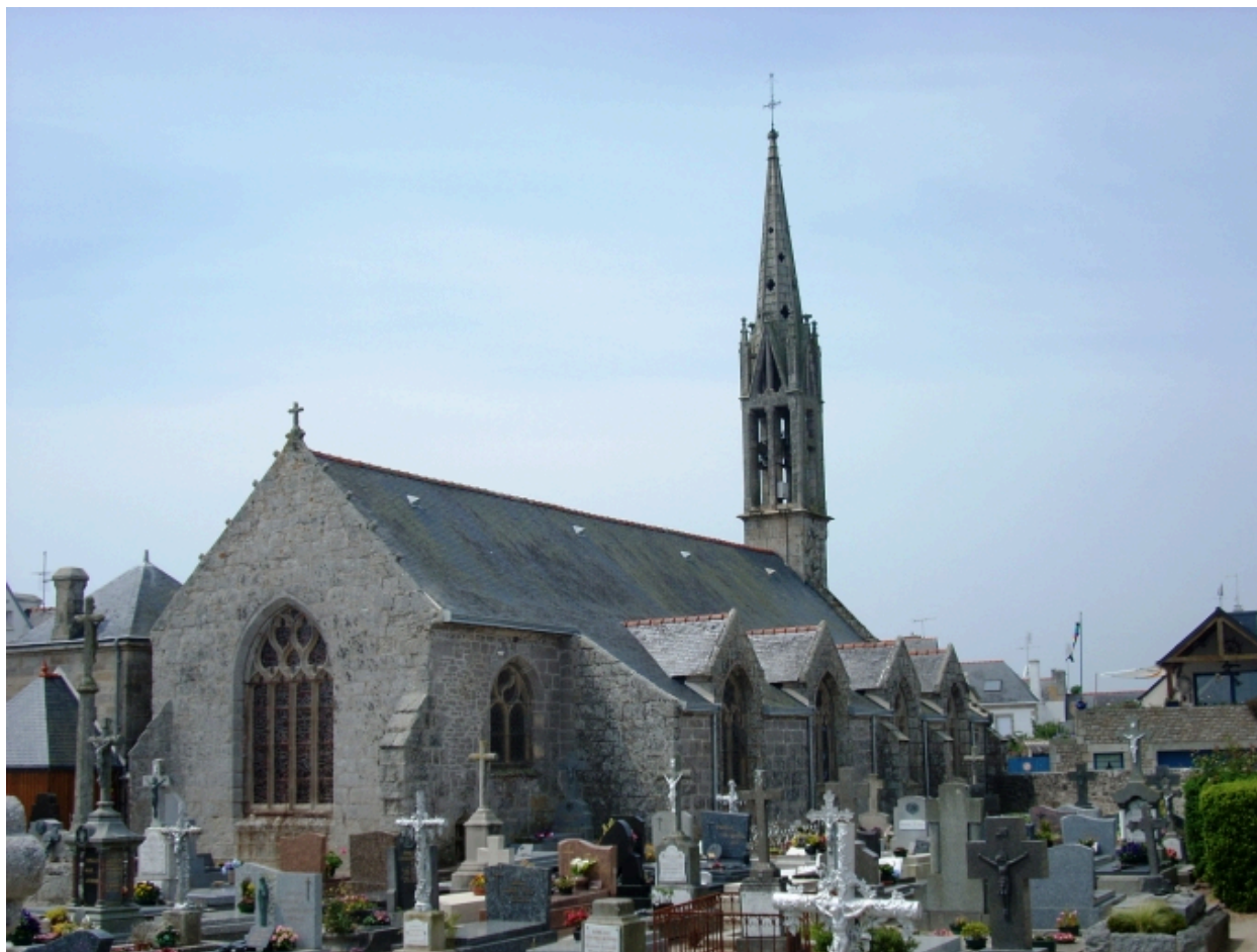
Île Tudy, église paroissiale Saint-Tudy : vue générale nord-est
