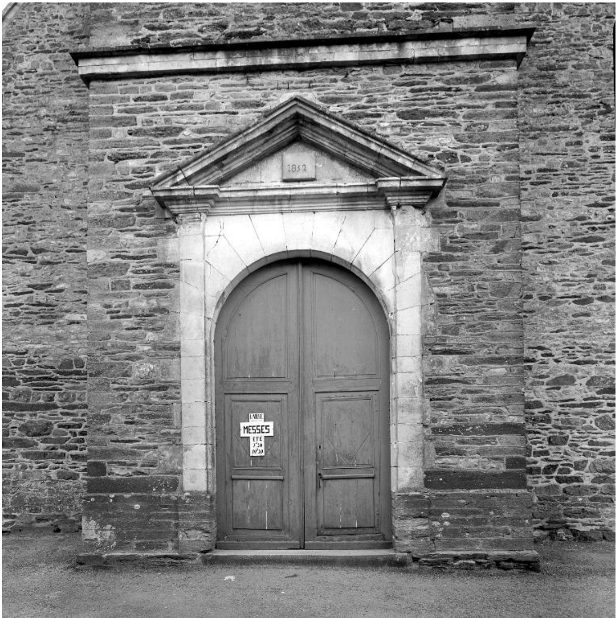
Elévation Ouest, porte : vue générale (Etat en 1968)
