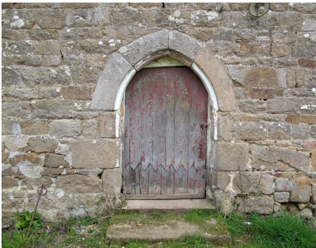
Vue de détail du logis : porte en arc brisé
