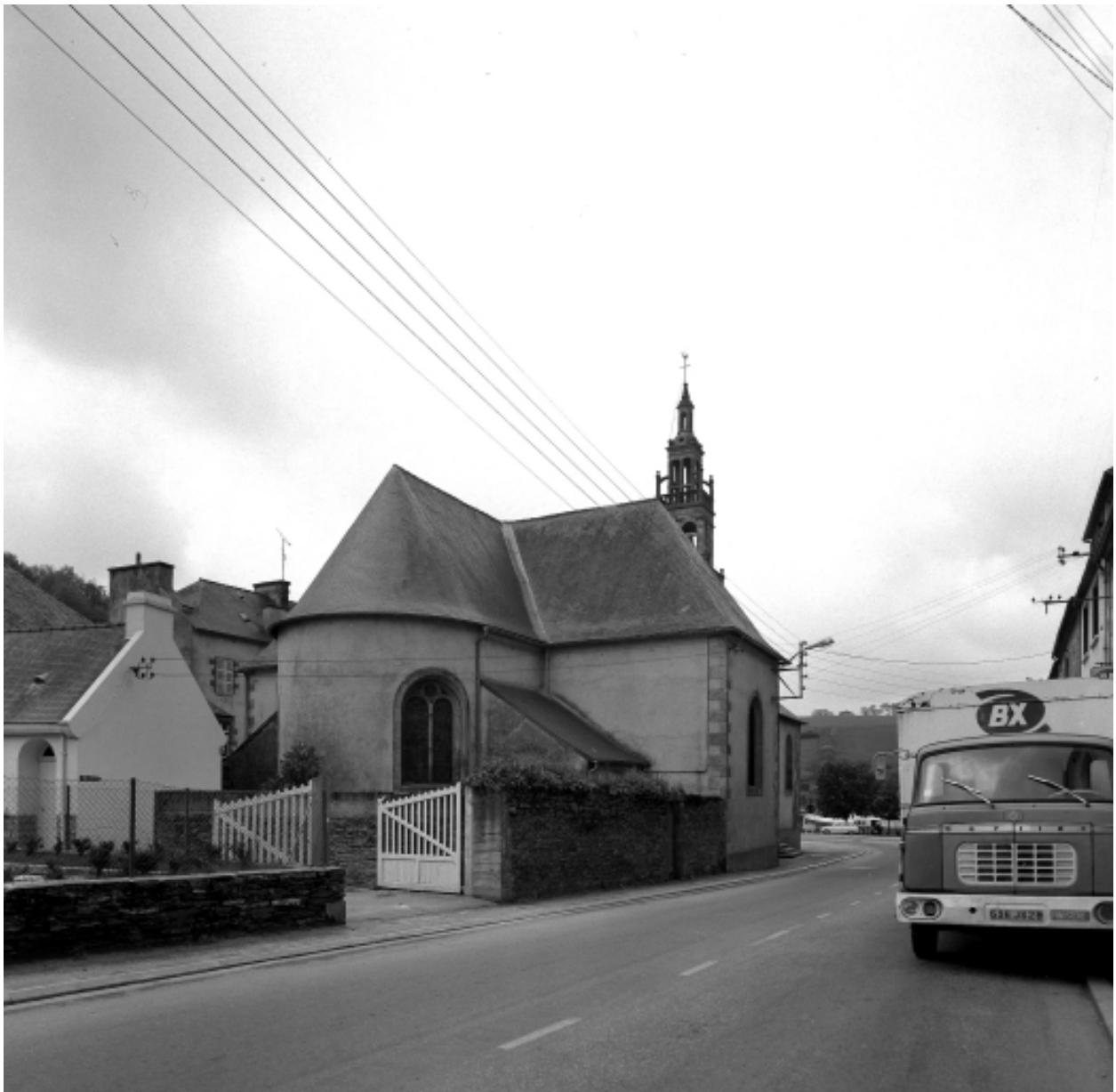
Port-Launay, église paroissiale Saint-Nicolas : vue générale nord-est, état en 1972
