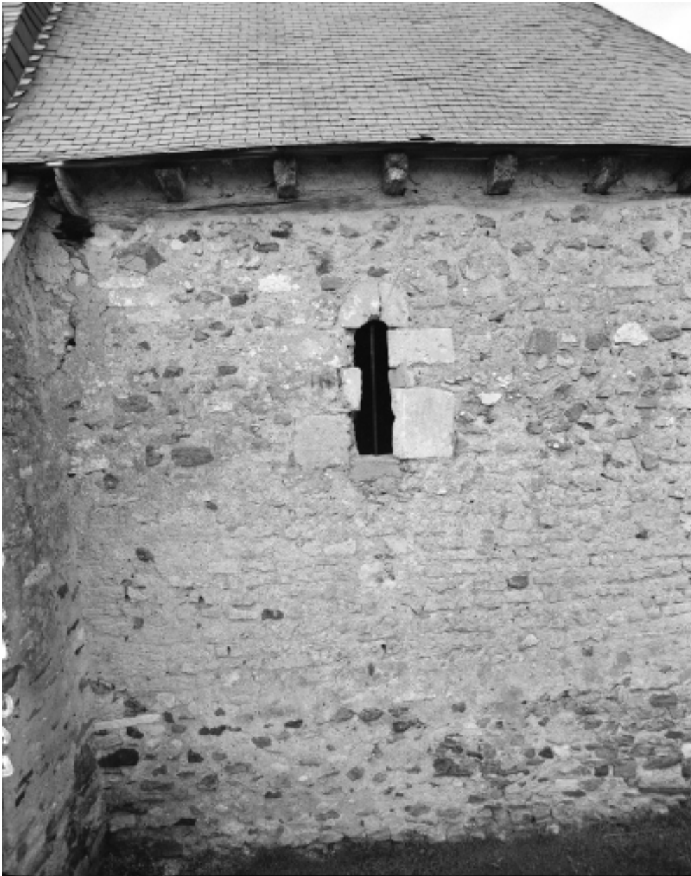
Détail ; mur nord, fenêtre romane
