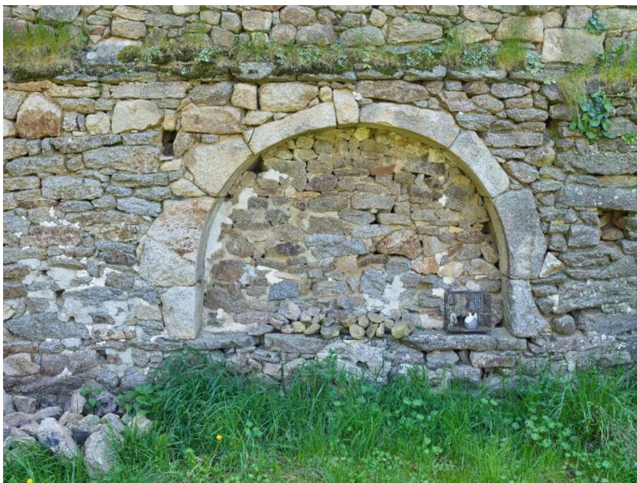
Enceinte intérieure, détail d'une baie en demi-arc comblée
