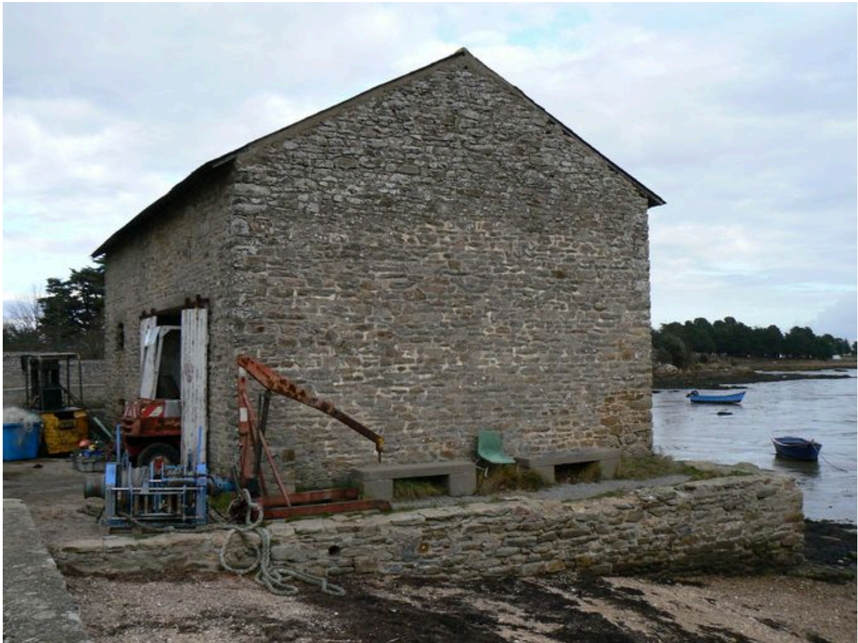
Vue générale d'un ancien magasin ostréicole, actuellement hangar d'une station biologique
