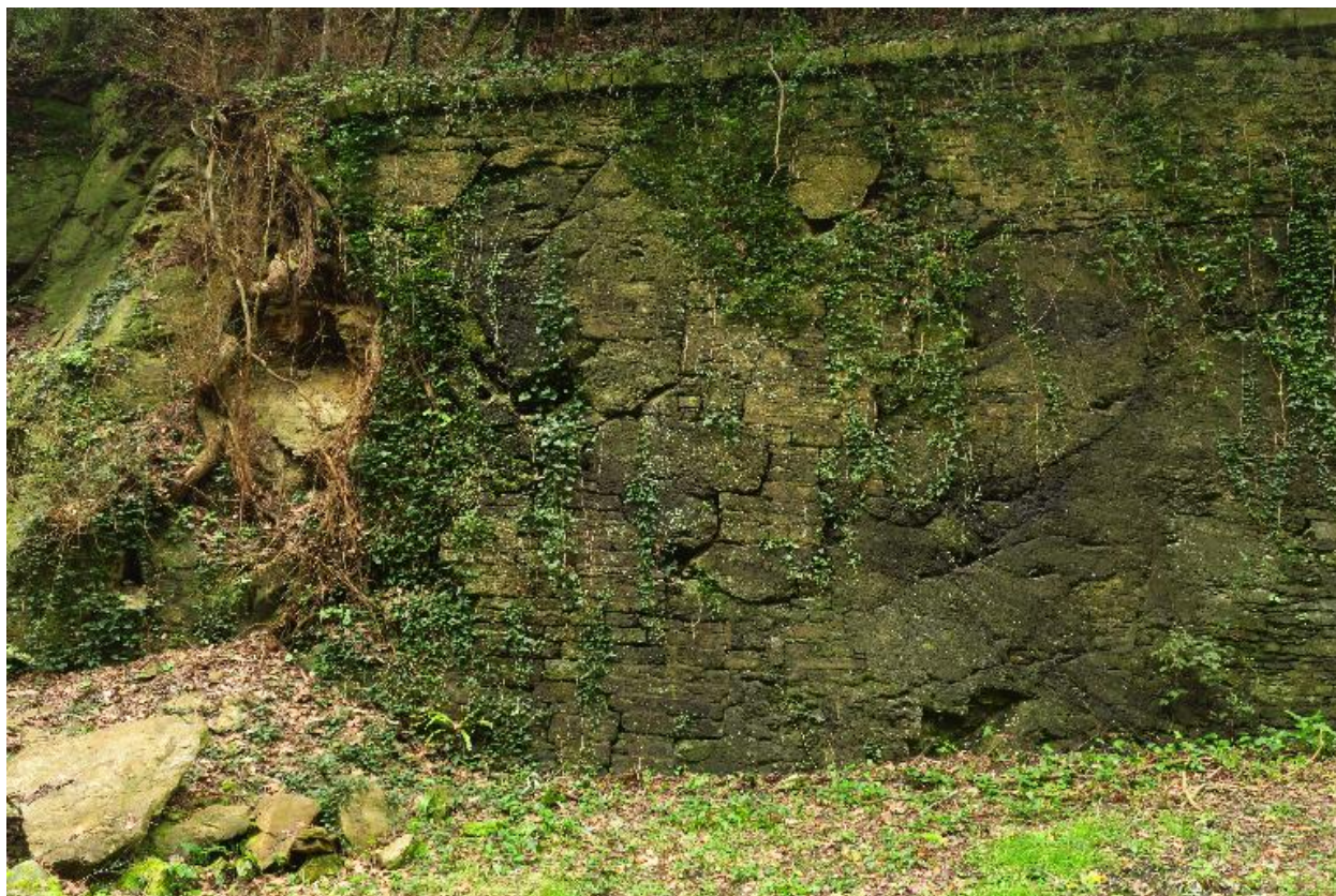
Le Palais, enceinte urbaine, courtine 21-22, escarpe.
