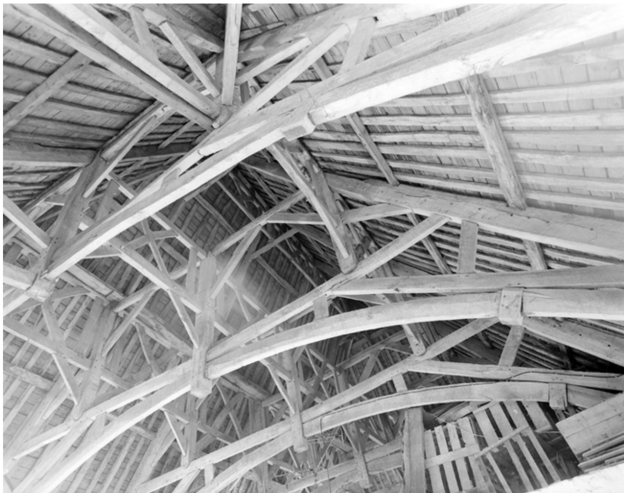
Vue de détail de la charpente.
