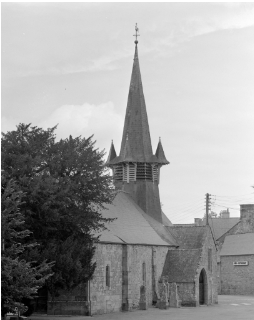
Elévation sud-ouest : vue générale
