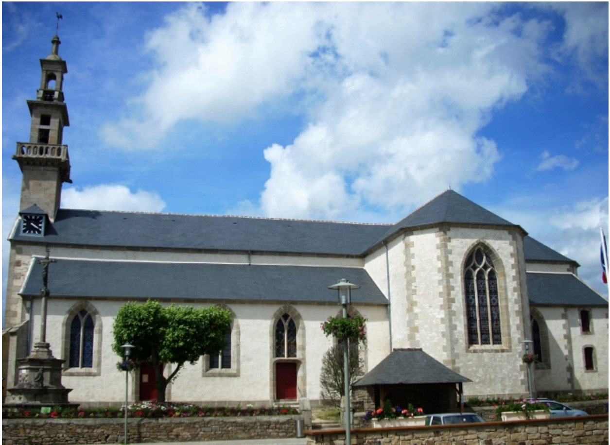
Plouvien, église paroissiale : vue générale sud
