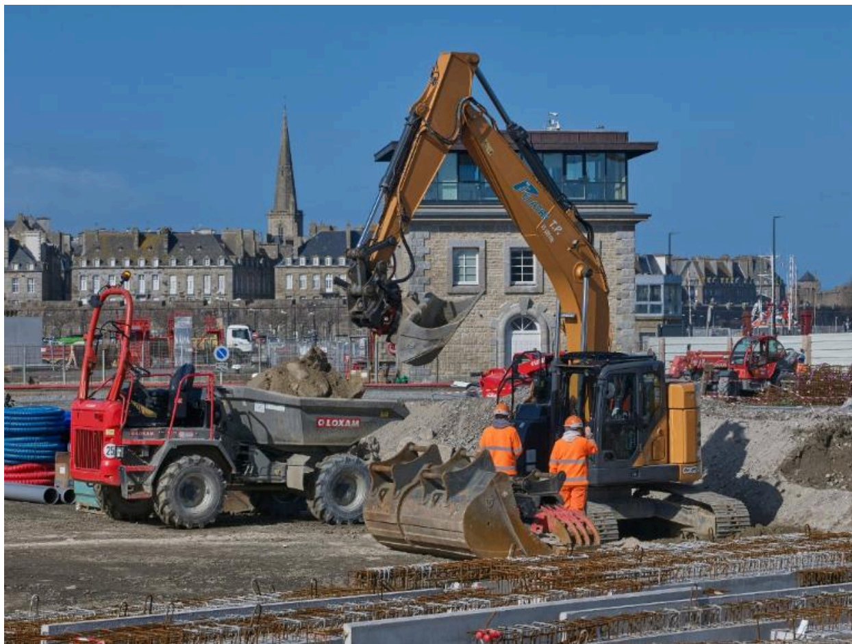
Vue du chantier du terre-plein du Naye (couverture photographique du 11 mars 2026)
