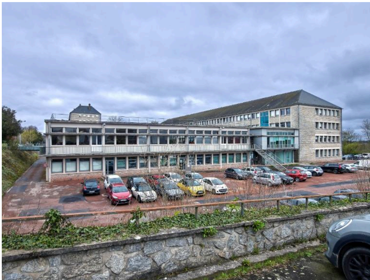
Vue d'ensemble, prise du sud-ouest. Au premier plan, les services communs. Patrice Simon, architecte, 1966.
