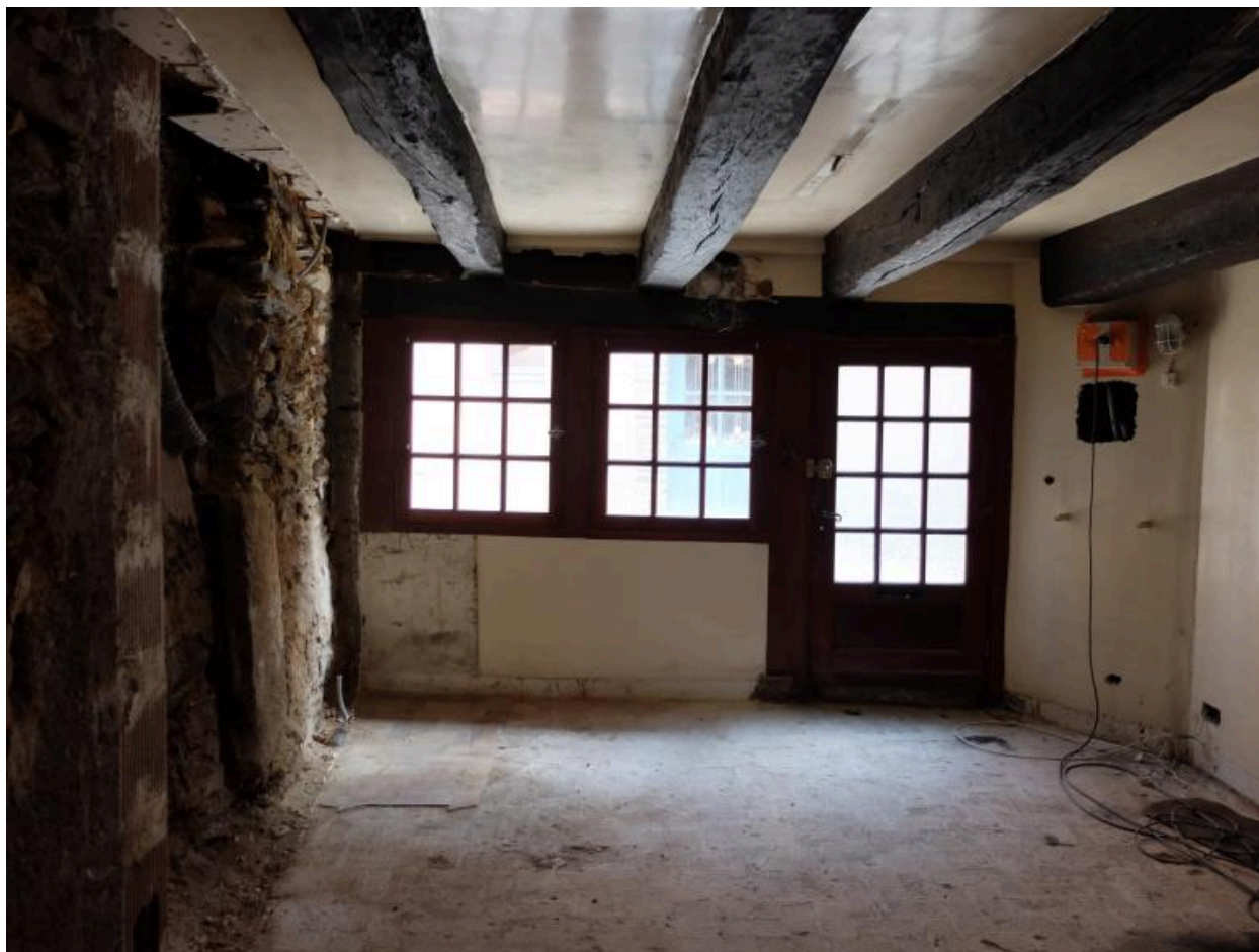
Maison à gauche. Rez-de-chaussée
