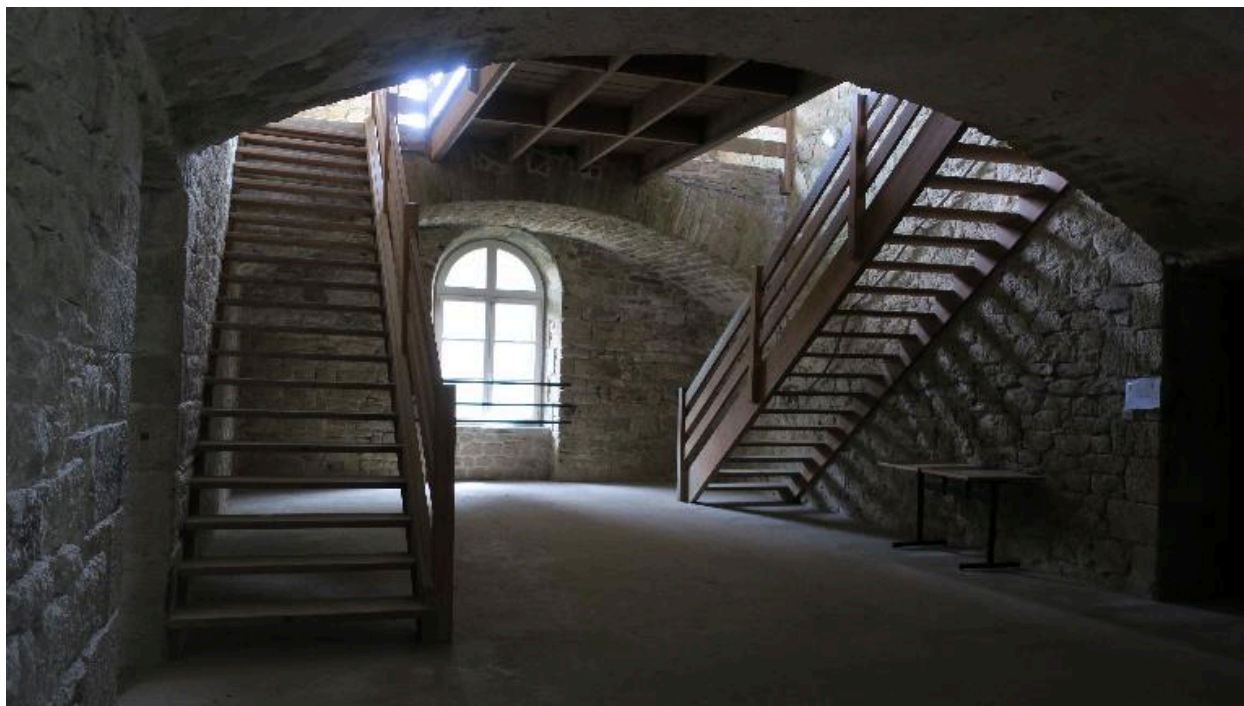
Hoedic, fort central, caserne à l'épreuve, cage d'escalier centrale.
