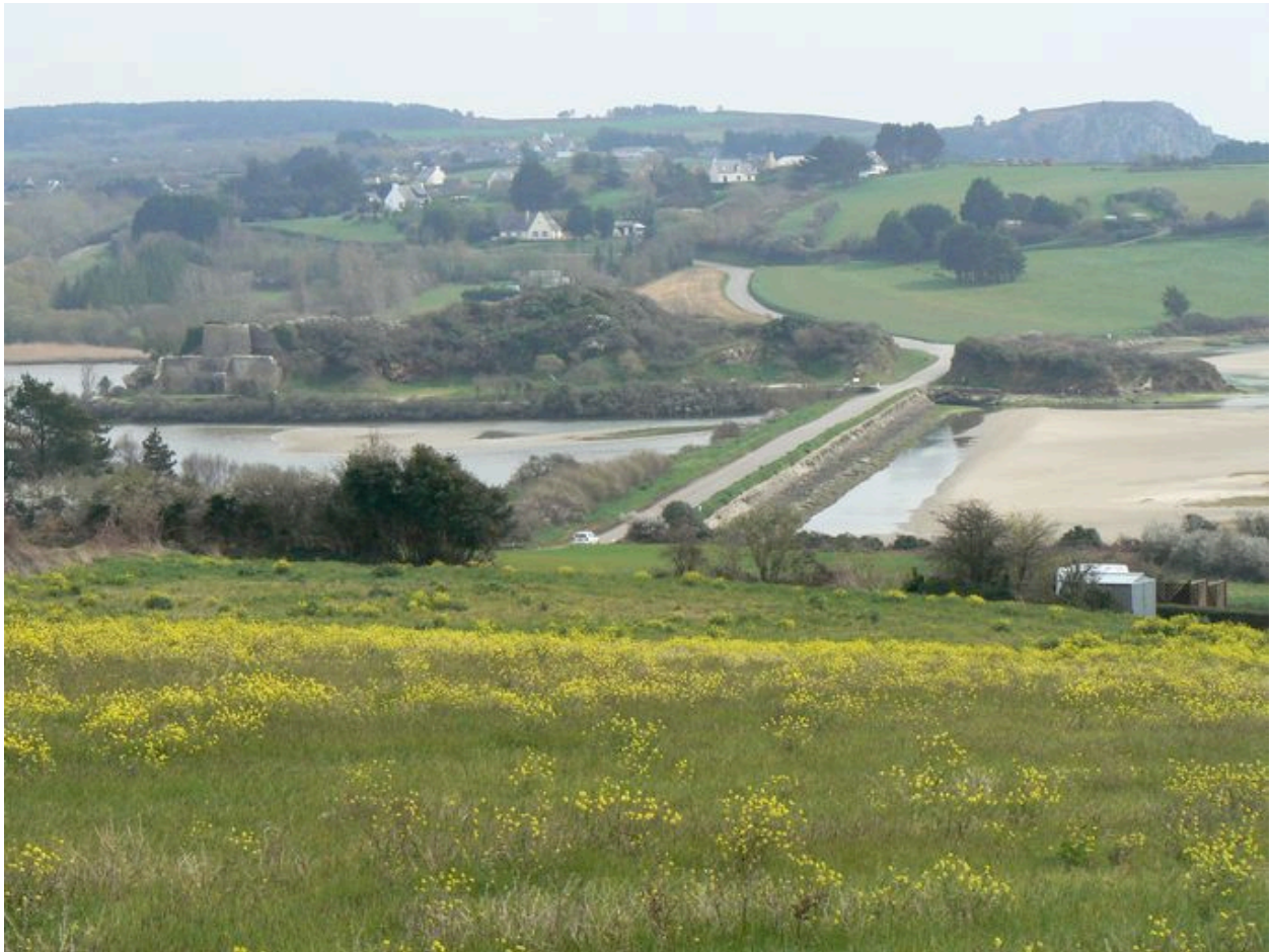
Vue générale de la digue-route de l'Aber
