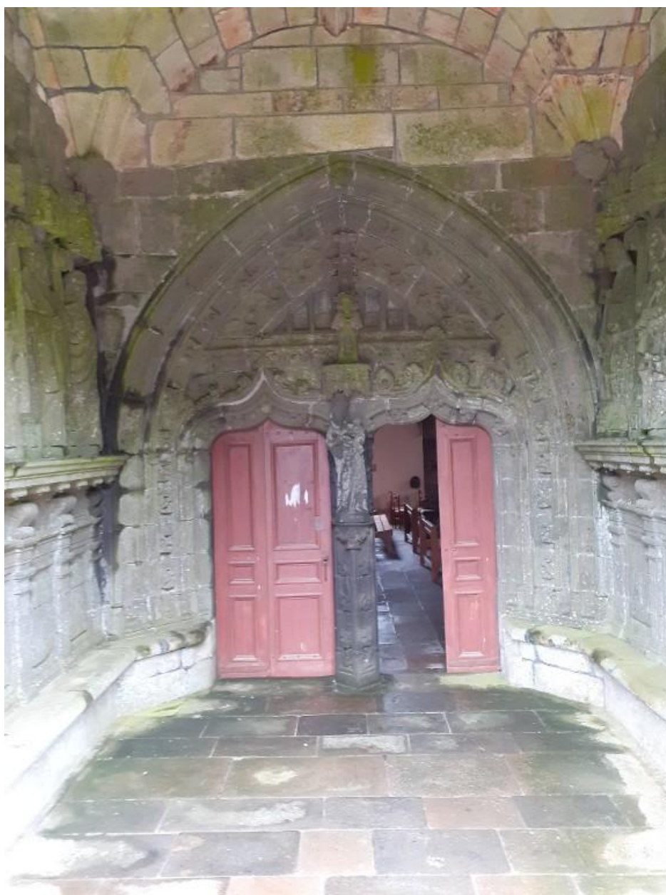
Intérieur du porche sud
