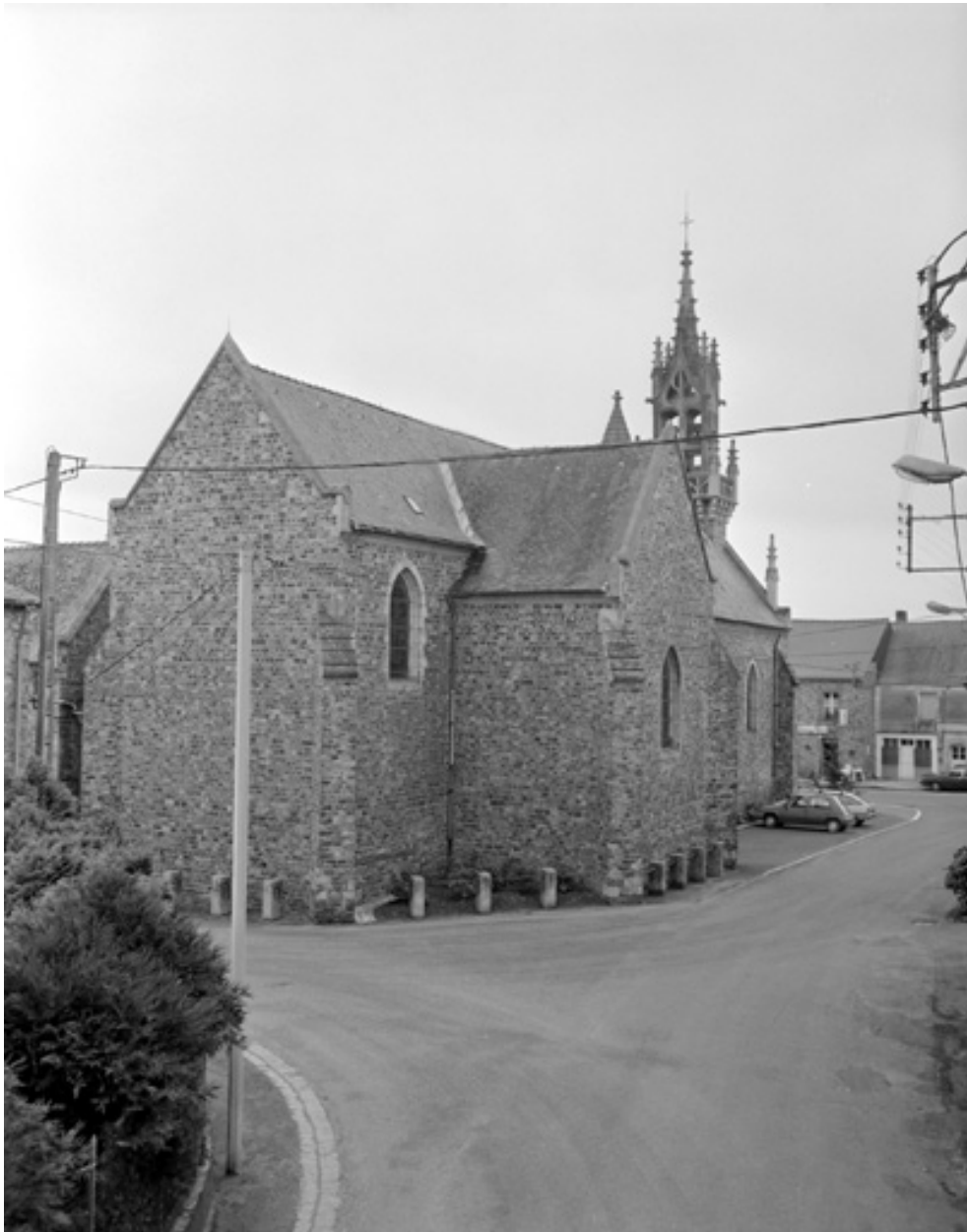
Elévation Nord-Est : vue générale
