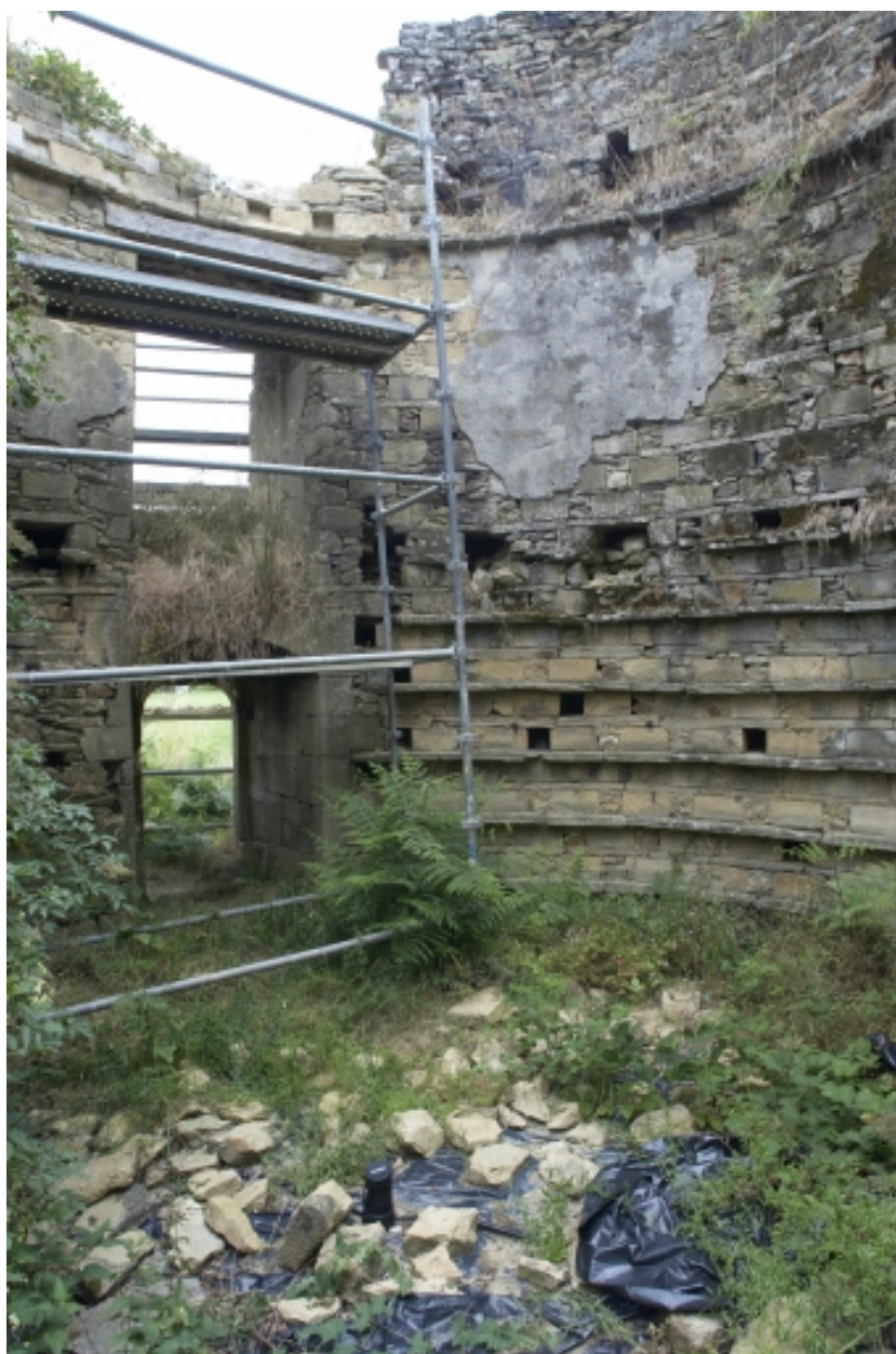
Colombier, vue intérieure
