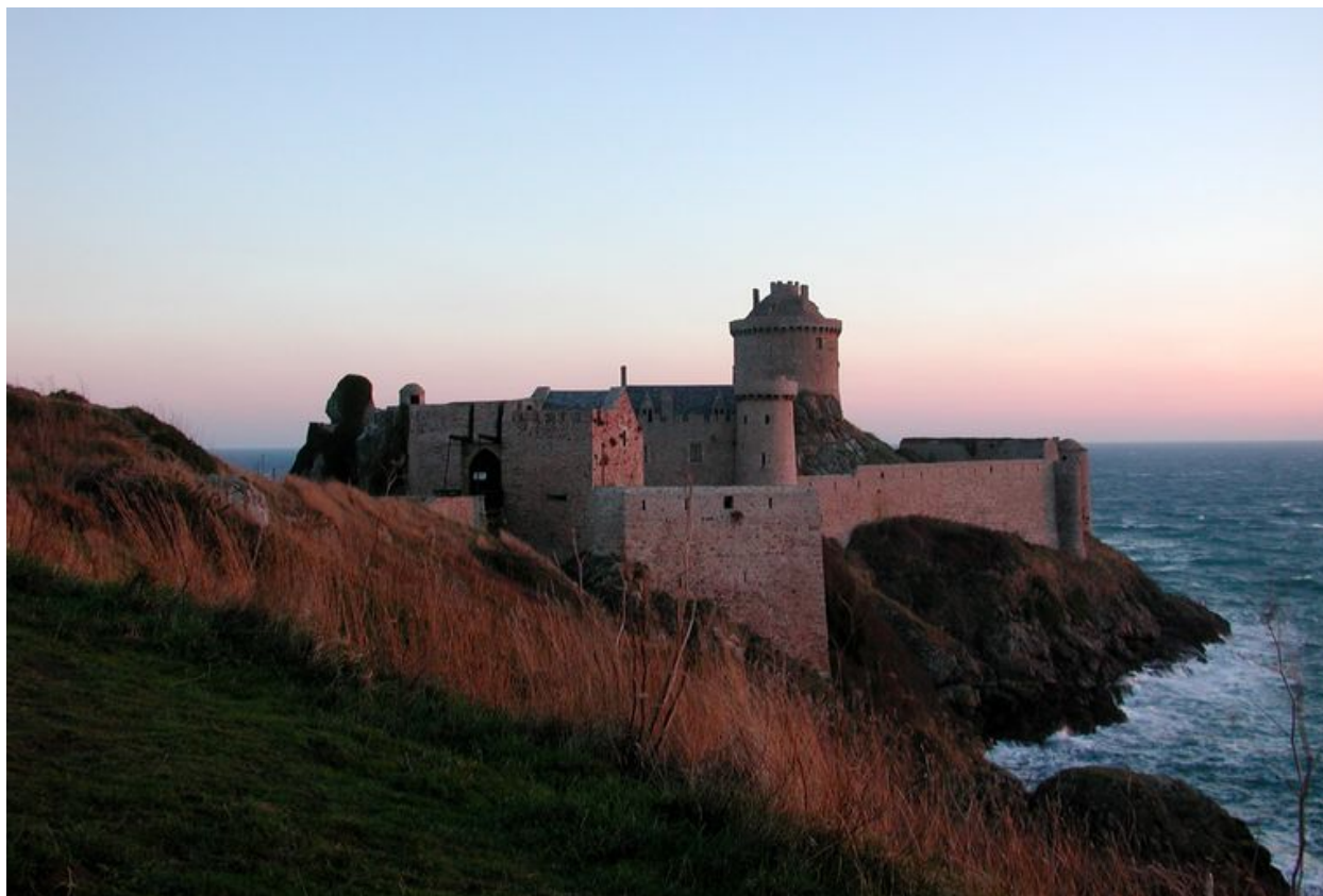
Vue du Fort La Latte
