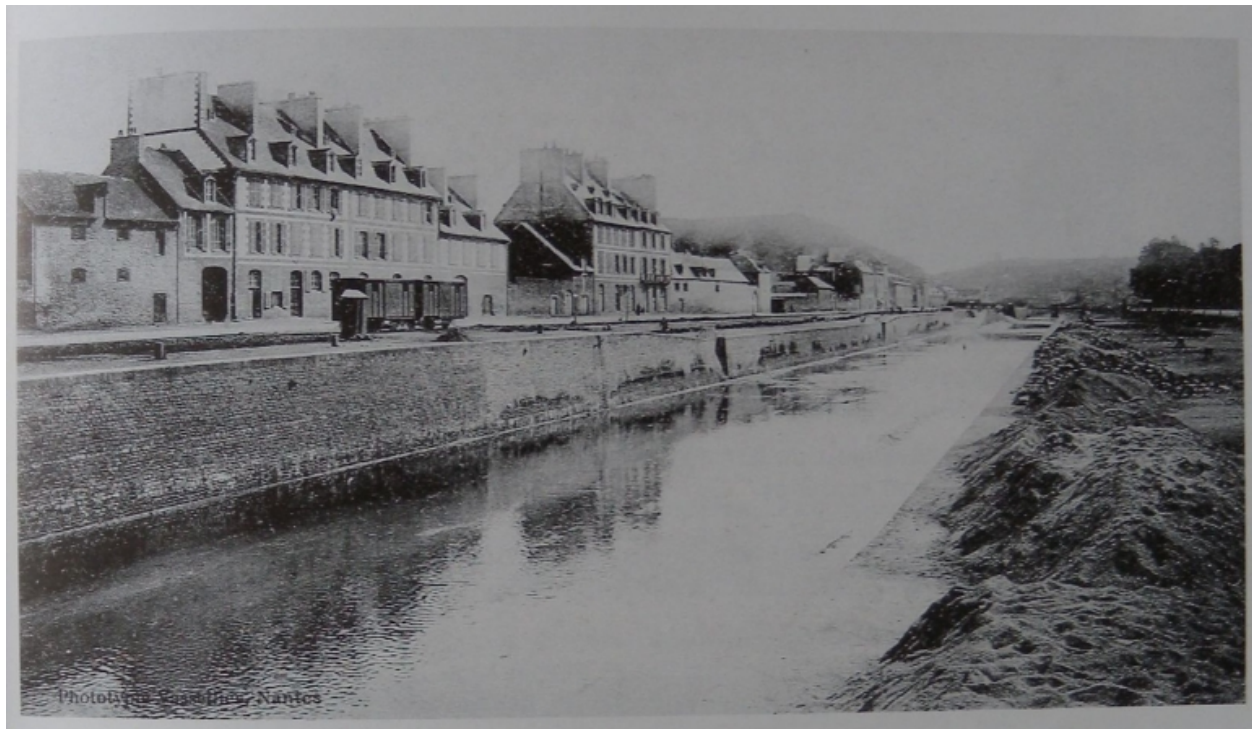
Vue des quais en amont du bassin à flot en 1913 : le mur de quai est terminé et le terre-plein empierré (carte postale, collection particulière)
