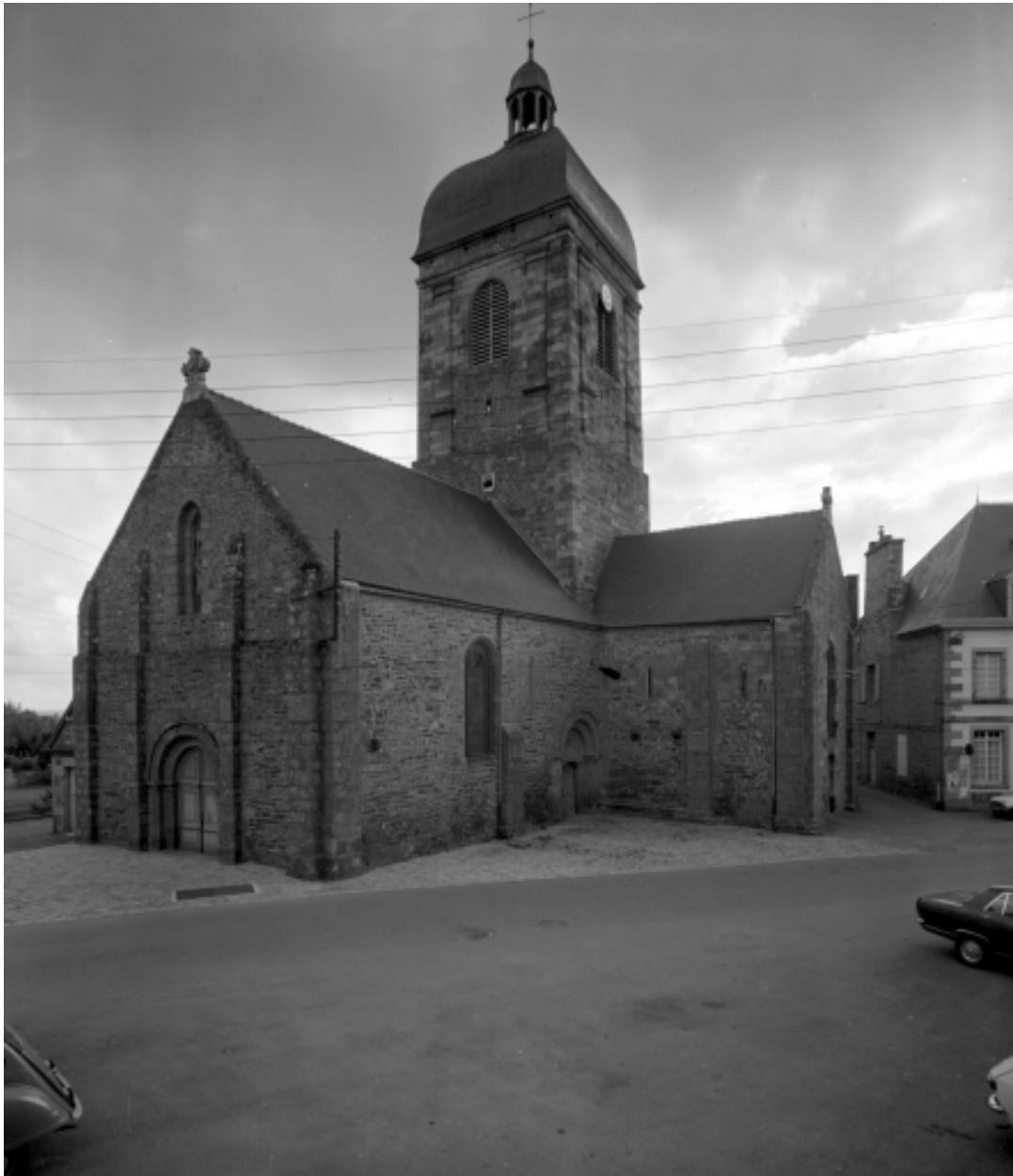
Elévation Sud-Ouest : vue générale
