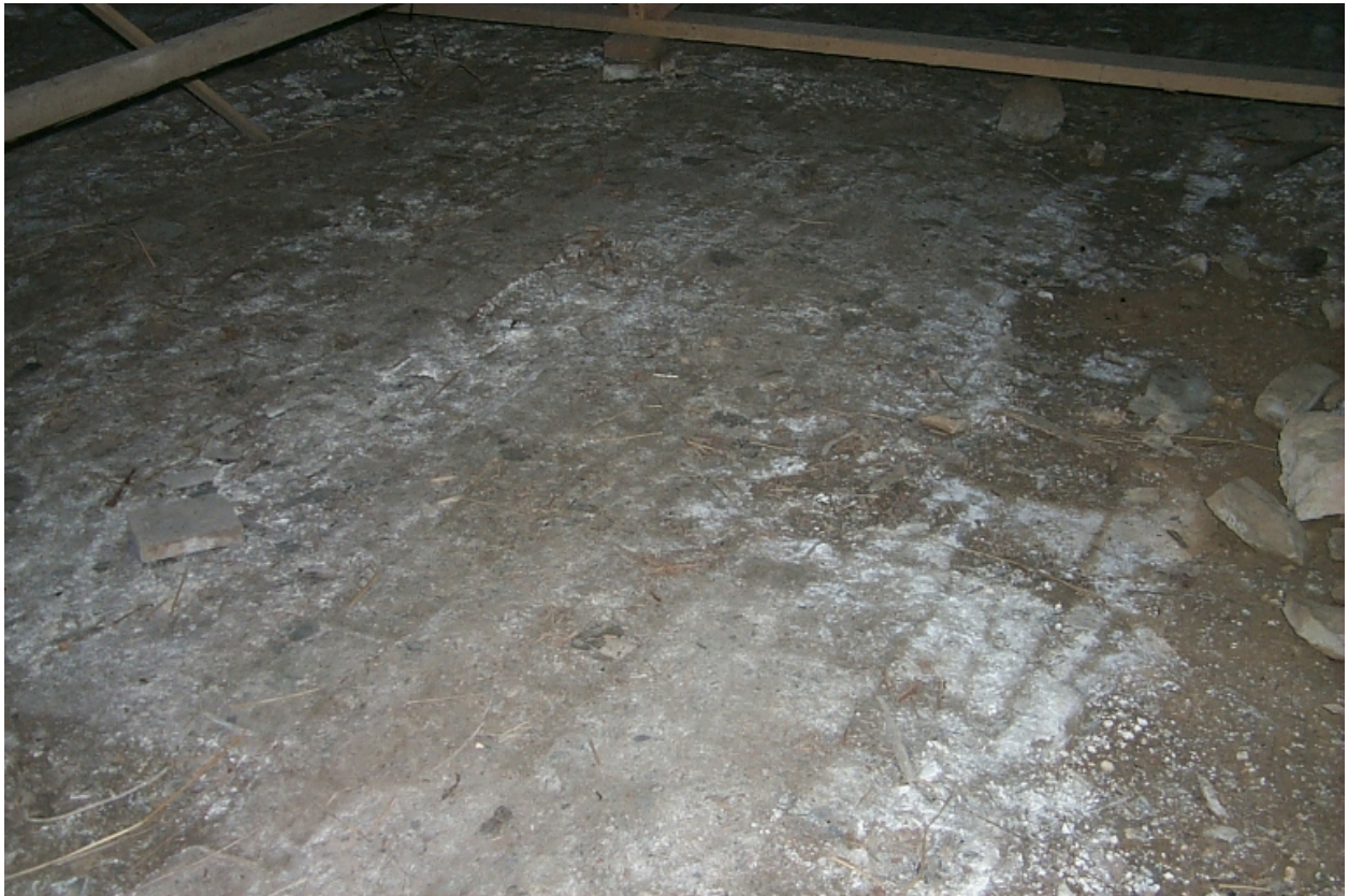
Intérieur, vestiges du pavage à l'entrée de la nef
