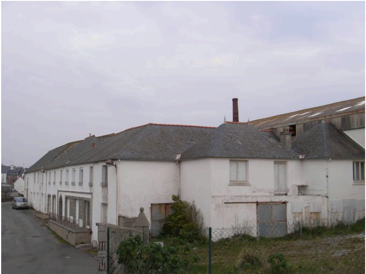
Ancienne conserverie Capitaine Cook, côté sud-est
