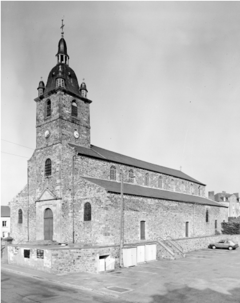
Elévation sud-ouest : vue générale
