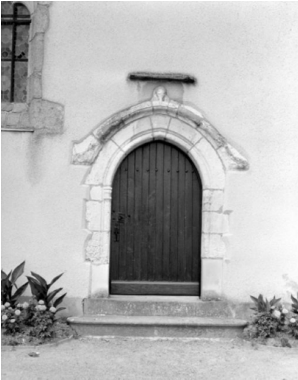
Mur sud ; partie est, porte
