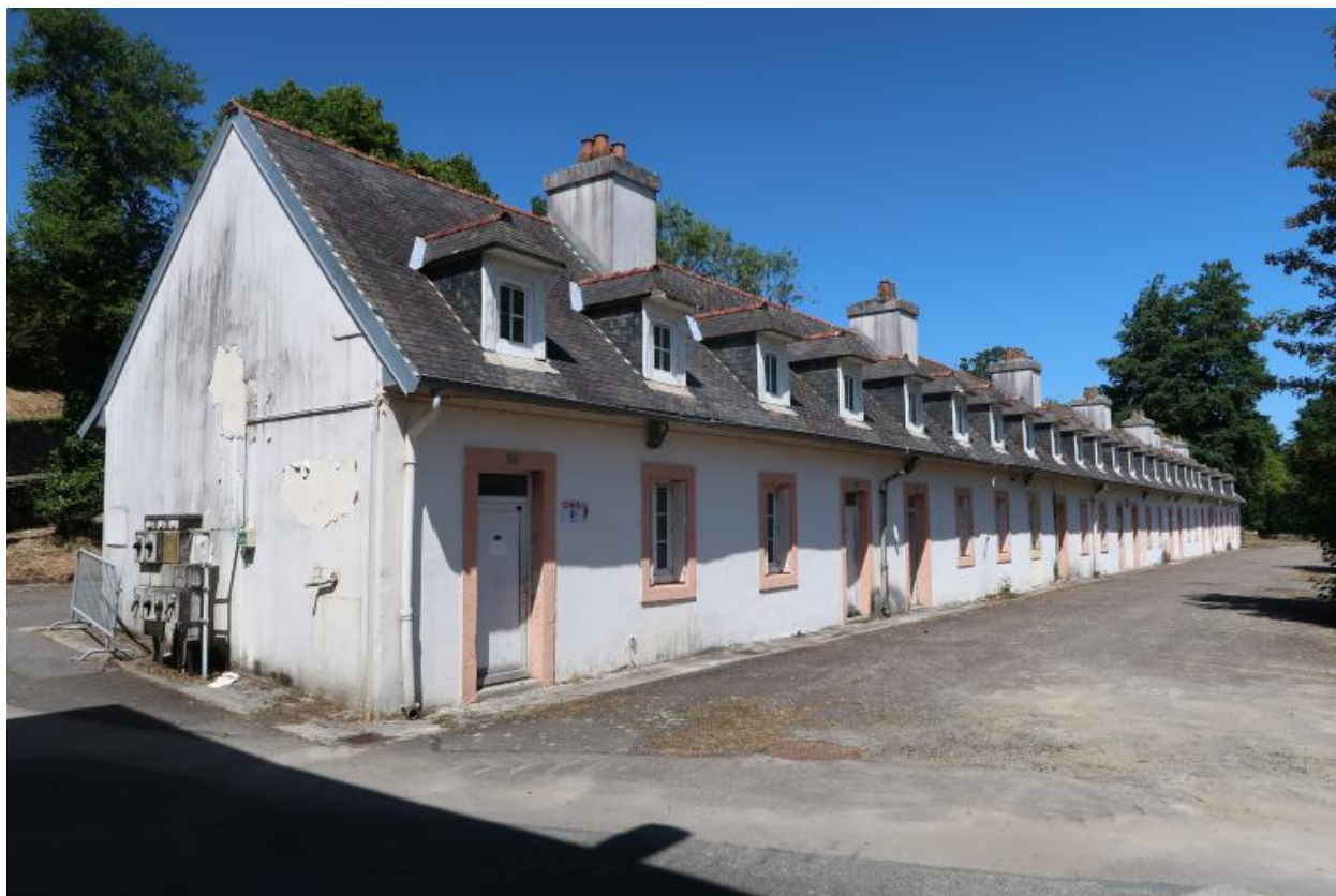
Vue générale du logement d'ouvriers actuellement bâtiment Duplessis : élévation sud donnant sur la Penfeld (état en 2022)
