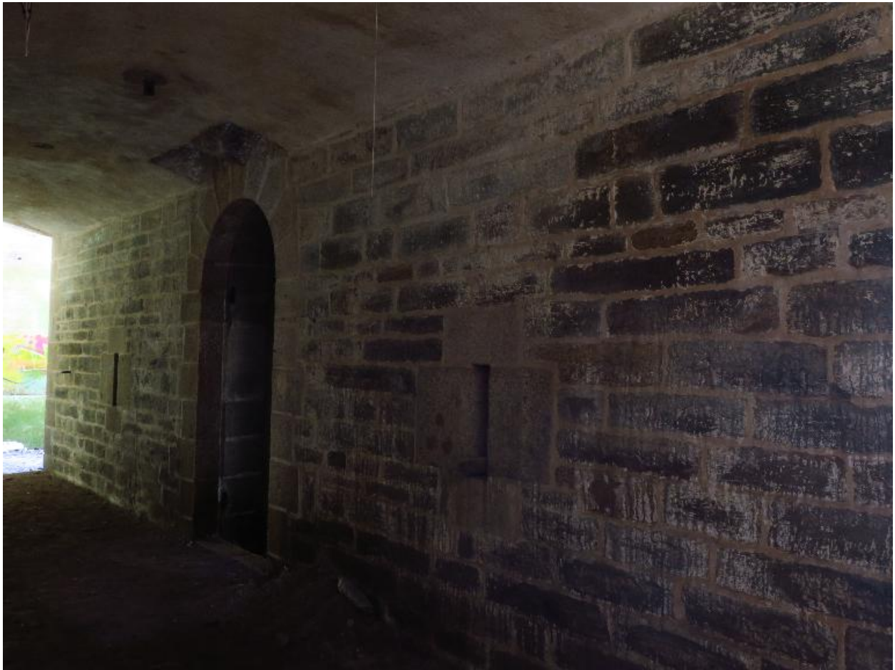
Groix, batterie du Bas-Grognon, corps de garde crénelé, façade arrière.
