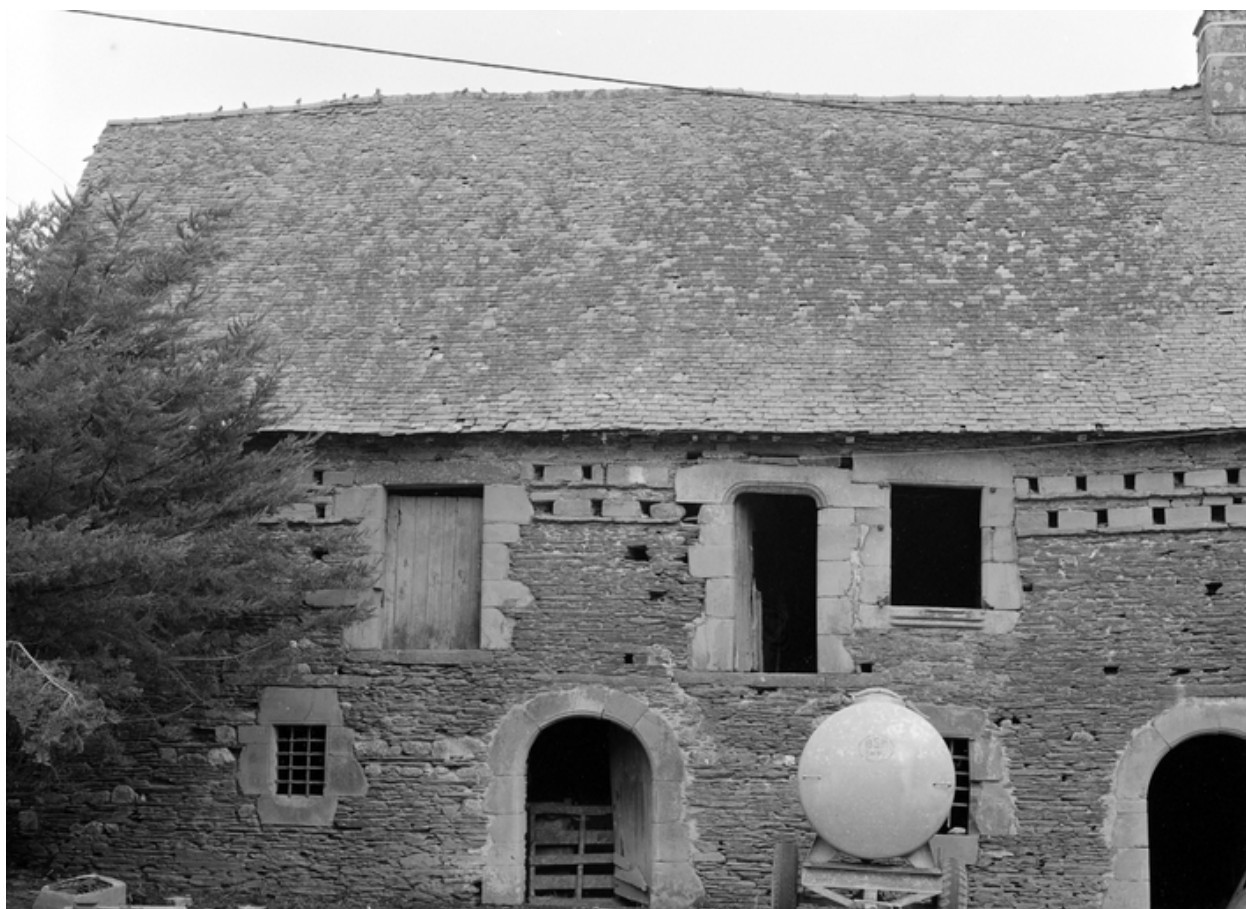
Dépendances nord, élévation sud.
