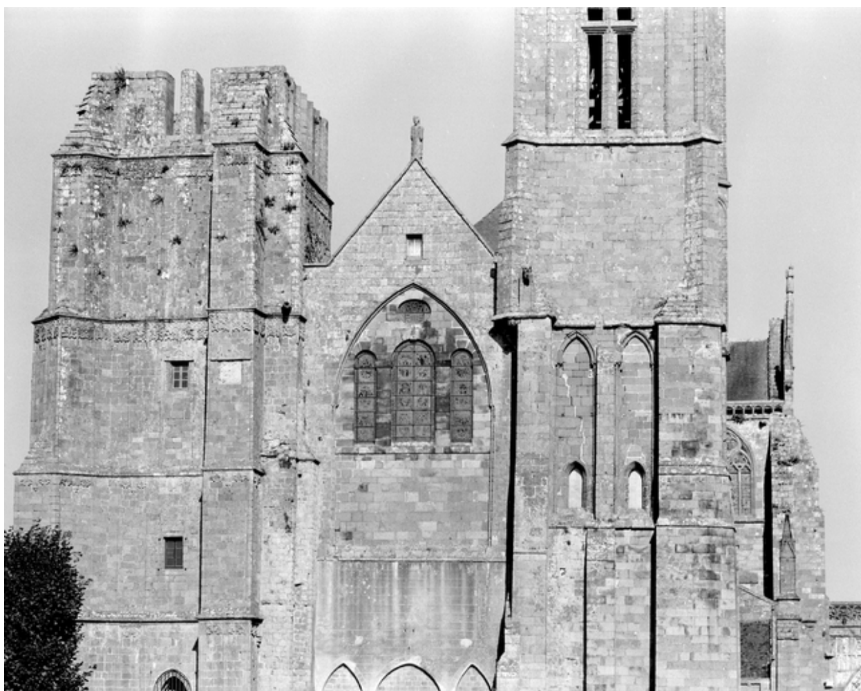
Façade ouest : deuxième niveau
