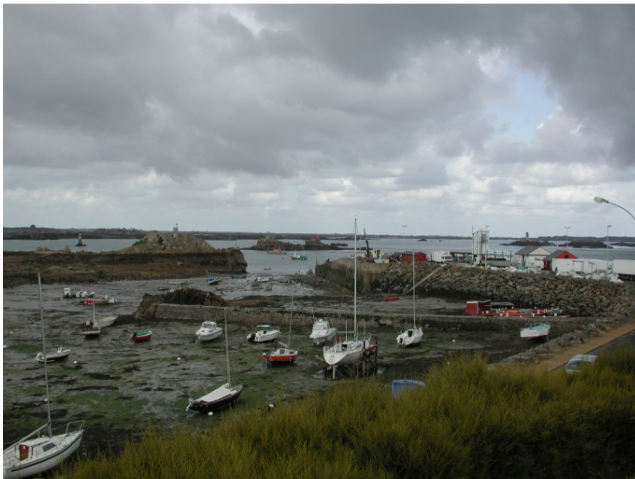
Vue générale de l'entrée du port avec la cale Est et le terre-plein aménagé
