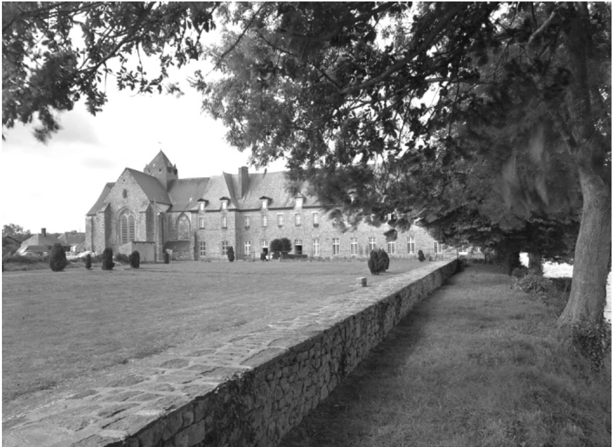
Vue de situation prise du parterre vers l'ouest
