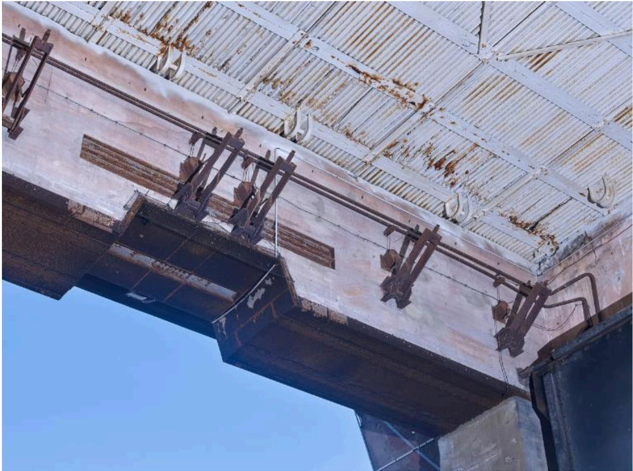
Vue du système de verrouillage de la porte blindée nord de l'alvéole du slipway. En position ouvert, chaque élément de fermeture était relevé par un treuil à manivelle. L'encoche témoigne de la nécessité d'accueillir des sous-marins de plus en plus hauts
