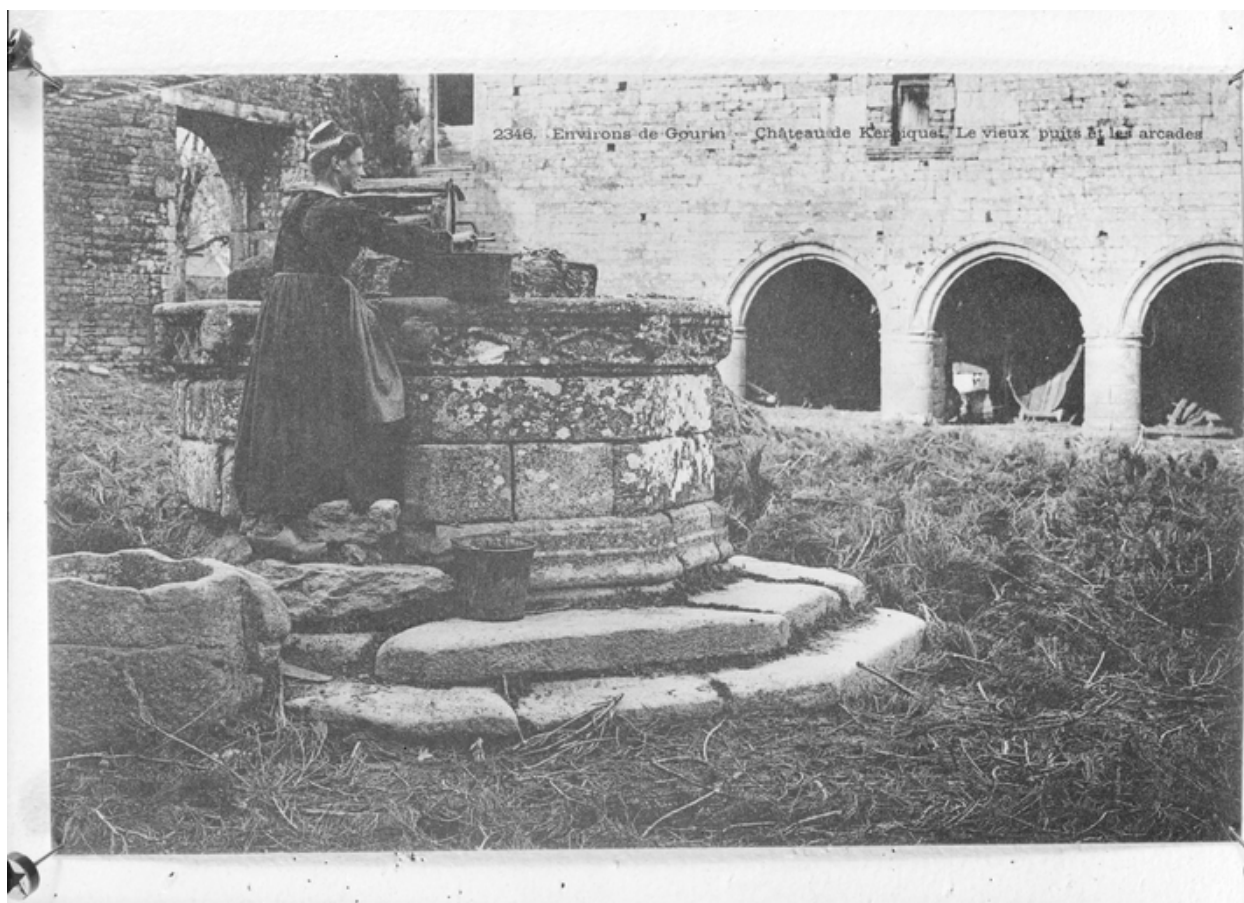
Manoir de Kerbiguet (Gourin) : Puits avant transformation
